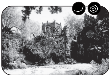
Casa particular, El Pedregal-México, O'Gorman, 1953.
